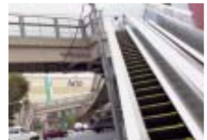
階段のほかに昇降用エスカレーターを設置
