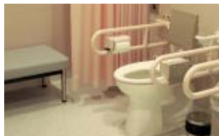
ユニバーサルデザインの視点で設計された多目的トイレ
