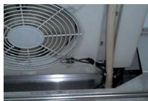
冷風機に取り付けられたセンサーで温度を感知、庫内を一定の温度に保つ
