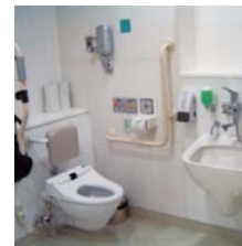
間口を広く取り、便座の位置や洗面台の高さなどを工夫した多目的トイレ。音声案内装置も設置
