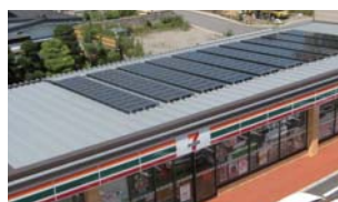
太陽光発電パネルを設置した店舗
