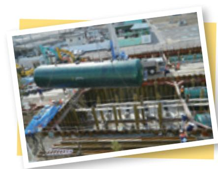
設置中の燃料タンク。震度7の大地震を想定した高い耐震性を備え、停電時でも給油が可能
